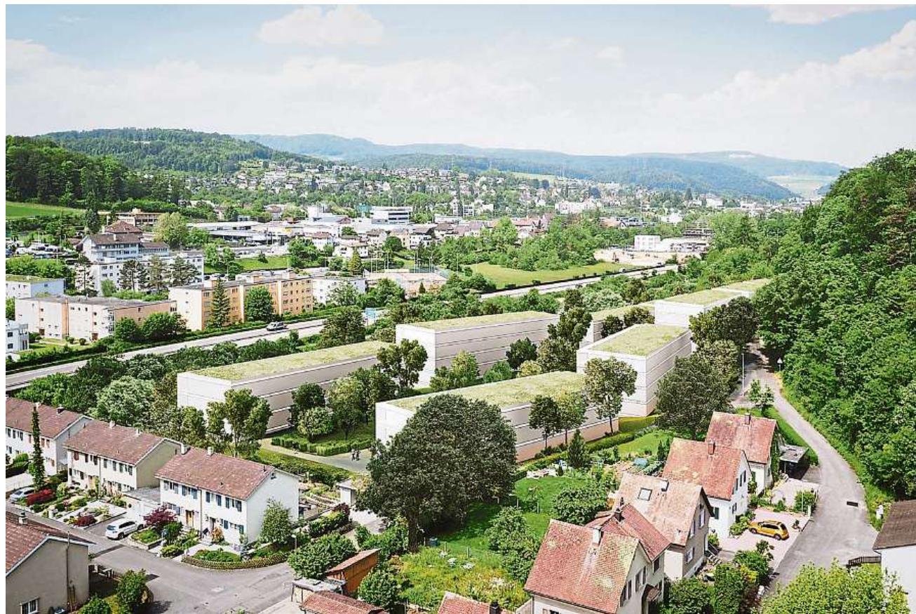
Auf der Grenze. Die Cheddite-Überbauung befindet sich auf Lausner und Liestaler Boden.
